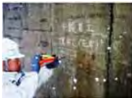
【コンクリート強度試験】
