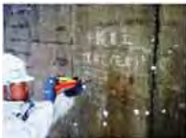
【コンクリート強度試験】
