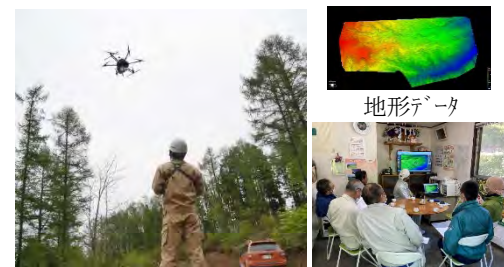
ドローンによるレーザー測量の様子 打合せの様子 (解析データ活用)
