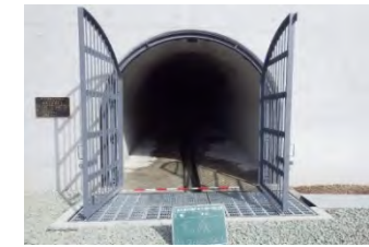
■排水トンネル工(左:坑口 右:集水状況)
