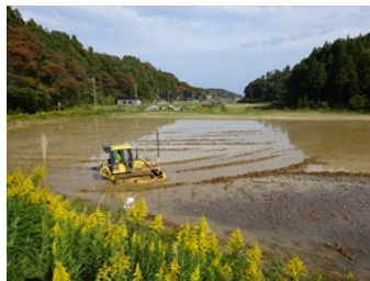
水整地の検証(珠洲市)
