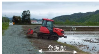
ターン農道の整備
