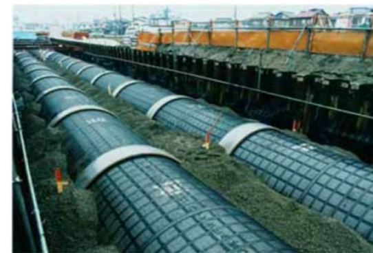
パイプライン側上部に特殊なネットを敷き、砕石で埋戻す
