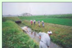
水路の泥上げ (日常の管理)
