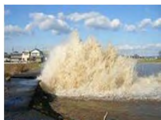
突発事故 (管水路の破裂事故)
