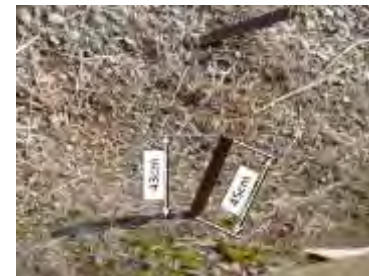
突き出たアングル（杭）
