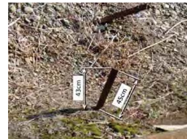
突き出たアングル（杭）
