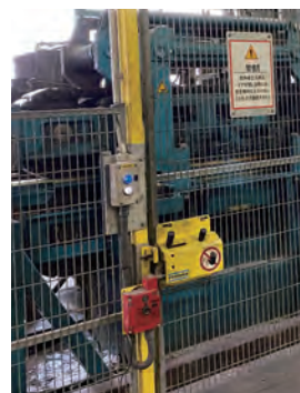
安全柵の設置
