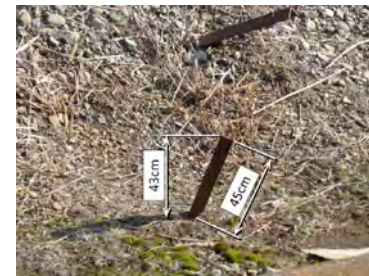
突き出たアングル（杭）
