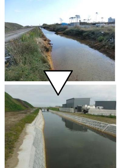
※津波で護岸が損壊した排水路の復旧が完了(上:被災後、下:復旧後)
