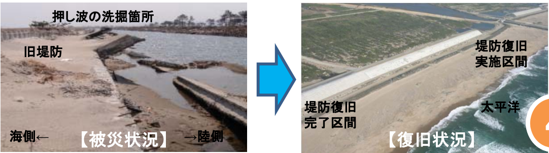
農地海岸の復旧事例(亶理・山元農地海岸地区)
