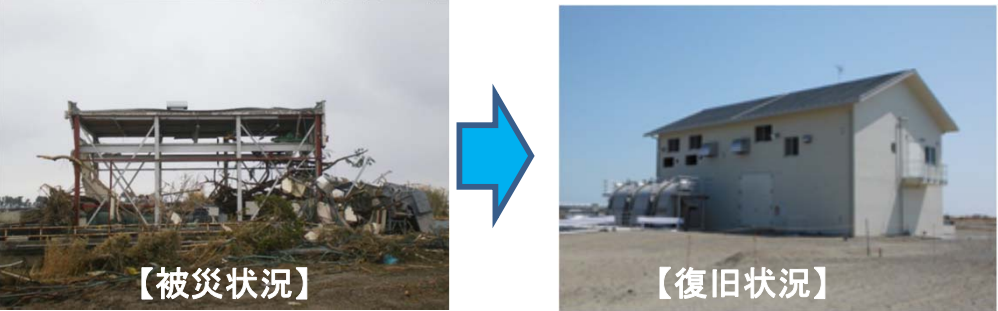
排水機場の復旧事例(仙台東地区)
