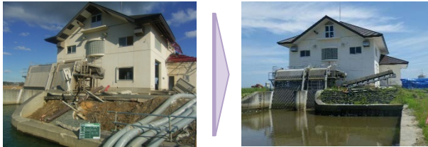
排水機場の復旧状況(谷地排水機場)
