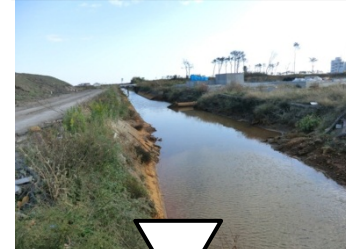
【仙台東】大堀排水路
