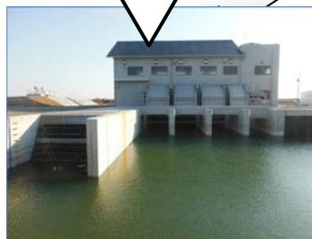
※損壊した建屋及びポンプ設備の復旧が完了(上:被災後、下:復旧後)
