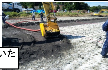
水による土壌攪拌・除去(水田)
