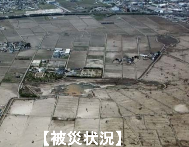
農地の復旧事例 (仙台市)
