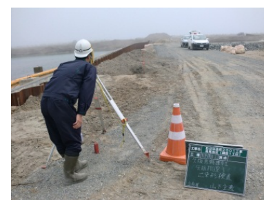
防災林造成工事の出来形確認の様子
