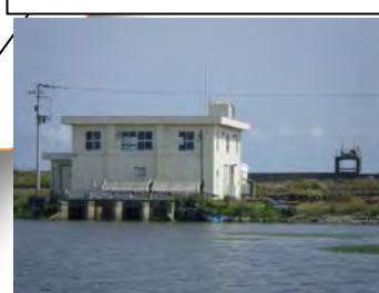
【南相馬】村上第二排水機場
