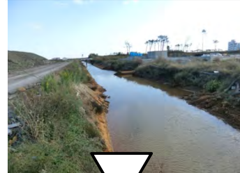
【仙台東】大堀排水路
