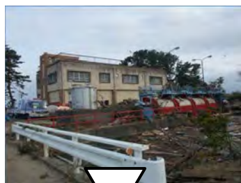
【名取川】閑上排水機場
