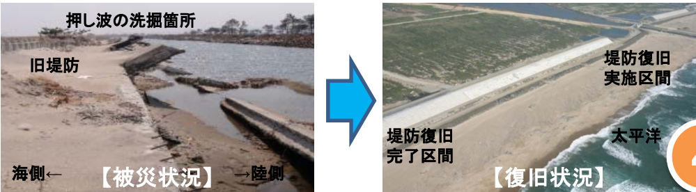
農地海岸の復旧事例(亶理・山元農地海岸地区)
