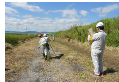
農地の災害復旧工事の現地測量作業の様子
