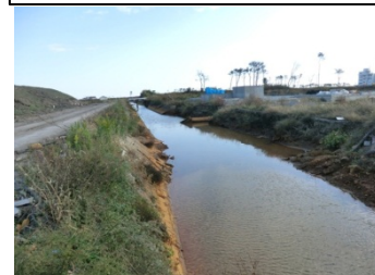
【仙台東】大堀排水路
