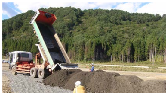
再生資材(津波堆積物)の搬入 (岩手県宮古市)
