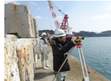
防波堤復旧工事の出来形確認の様子
