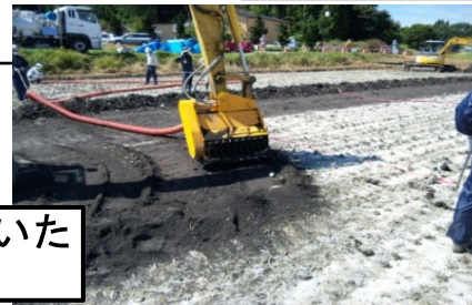
水による土壌攪拌・除去(水田)
