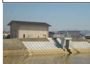
【定川】中区第二排水機場
