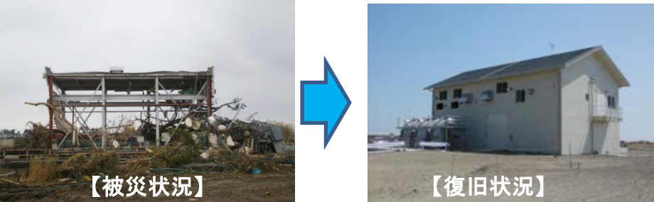
排水機場の復旧事例(仙台東地区)
