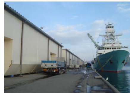
嵩上げた岸壁と仮復旧した水産物卸売市場
