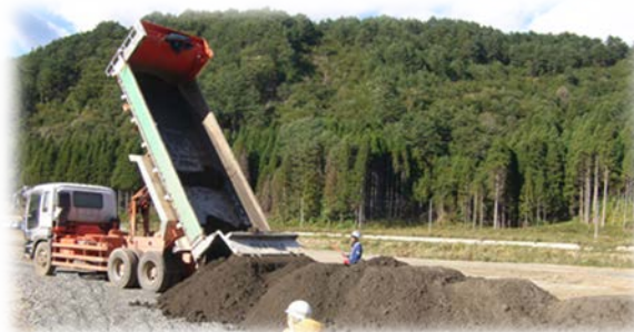
再生資材(津波堆積物)の搬入(岩手県宮古市)
