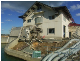
排水機場の応急復旧状況（谷地排水機場）
