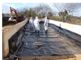
牛ふん堆肥保管用の遮水シート敷設
