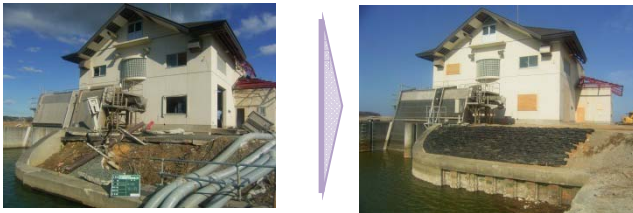
排水機場の応急復旧状況（谷地排水機場）
