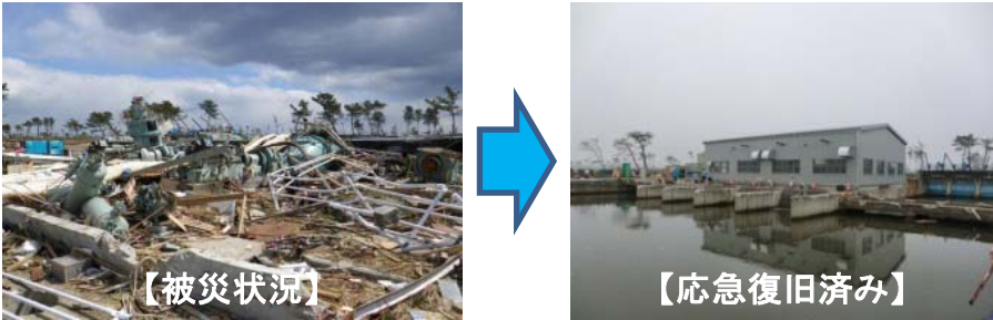
排水機場の復旧事例(仙台東地区)
