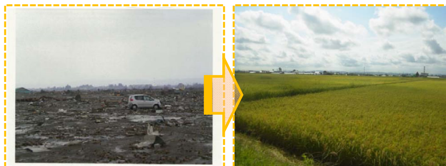
被災農地の復旧事例(仙台東地区)
