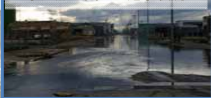
水産加工団地の冠水状況
