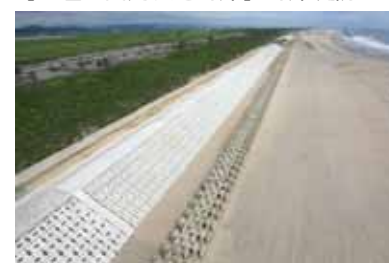
※一部、完成した堤防
