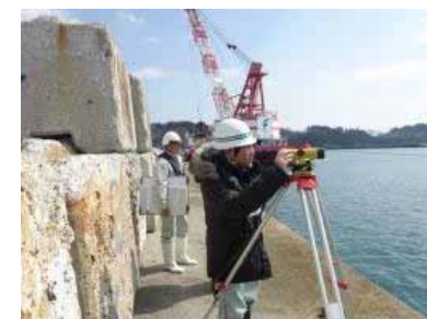
防波堤復旧工事の出来形確認
