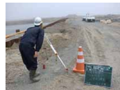
防災林造成工事の出来形確認
