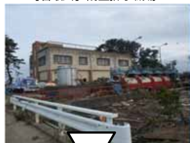
【名取川】関上排水機場
