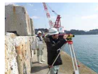
防波堤復旧工事の出来形確認
