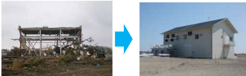
排水機場の復旧事例（仙台東地区）
