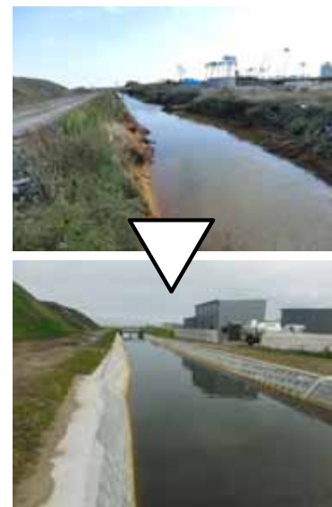
【仙台東】大堀排水路
