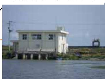
【南相馬】村上第二排水機場
