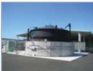
バイオガス発電
