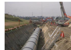
水路のパイプライン化
