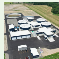
バイオガスプラント (令和7年10月稼働)
