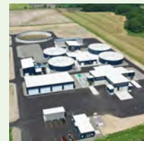
バイオガスプラント (令和7年10月稼働)
