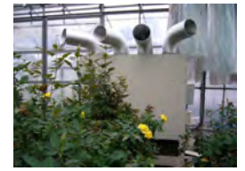
燃油使用量の低減に資する施設園芸用ヒートポンプ
