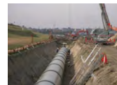
水路のパイプライン化
