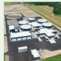
バイオガスプラント (令和7年10月稼働)
