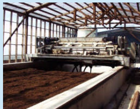
メタンの排出抑制、 良質な堆肥生産に資する 堆肥処理施設
