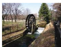
農業用水路に設置さ れた小水力発電施設
