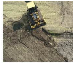
農業ブルドーザによる畔倒し
