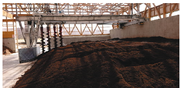
堆肥原料の自動攪拌機
