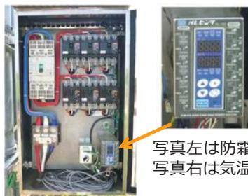
写真左は防霜ファン制御パネル内部全体。写真右は気温差制御を行う機器。
