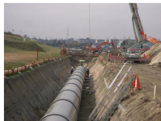
水路のパイプライン化
