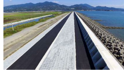
海岸堤防の嵩上げ
