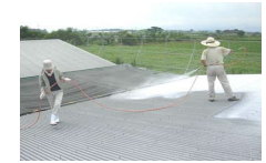
消石灰等の塗布
