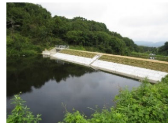
老朽化したため池の全面改修
