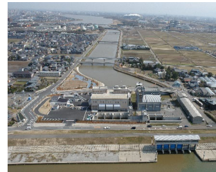
排水機場の整備
