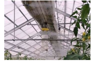
細霧冷房装置の設置
