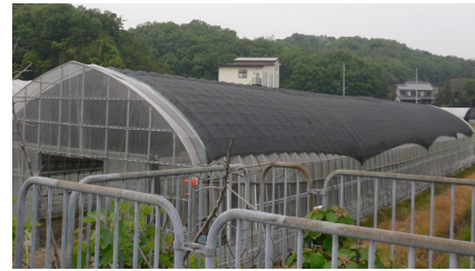
遮光ネットの設置
