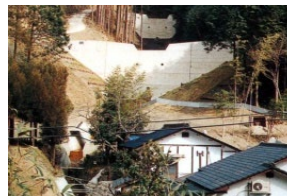
治山施設による山地災害の未然防止
