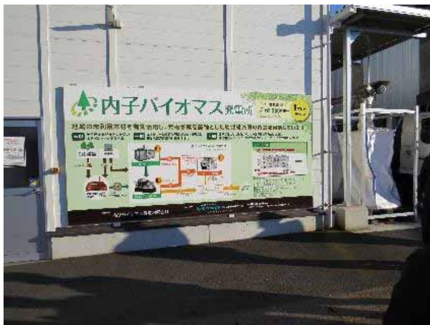
内子バイオマス発電所
