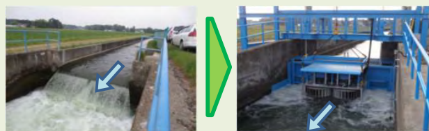
発電地点（設置前）
