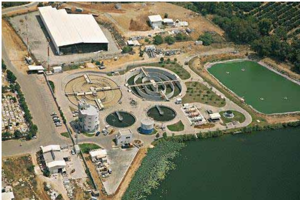
図 2.4-4 排水処理施設
