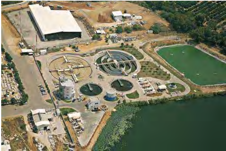
図 2.4-4 排水処理施設
