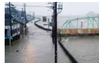
2011年台風第12号による熊野川(三重県南牟婁郡紀宝町の越水状況 提供:国土交通省)
