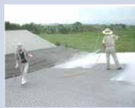
畜舎屋根への石灰塗布
