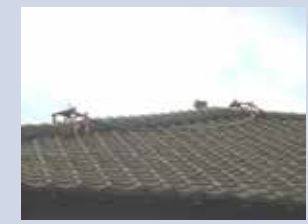
畜舎屋根へのスプリンクラー設置
