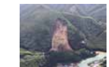
平成23年台風第12号災害(奈良県)
