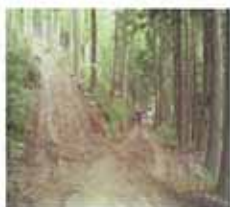
作業道・作業路の作設
