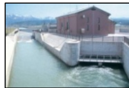
小水力発電施設
