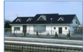
集落排水処理施設
