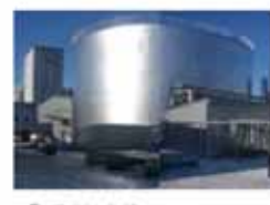
③ 液糖貯蔵タンク
