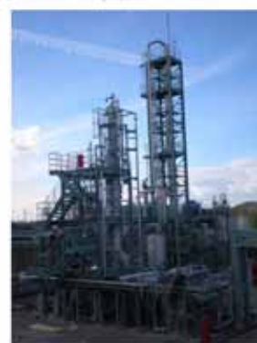
③蒸留施設 (左側:蒸留塔、右側:もろみ塔)
