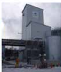
⑧ 蒸留・脱水棟 (08.11.30)
