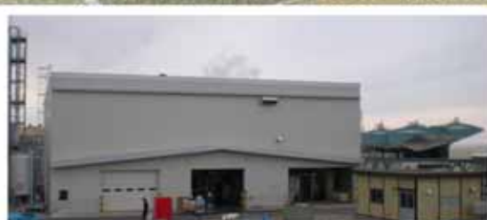
⑥ガス化プラント棟、分析室
