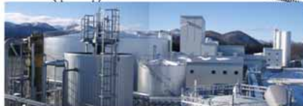
⑤ 糖液貯蔵タンク、排水嫌気処理前沈殿槽、蒸留・脱水棟、原料貯蔵サイロ
