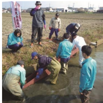
④集落総出で魚道を設置
