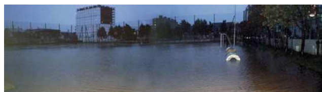
（事例）校庭を活用した流域貯留施設
