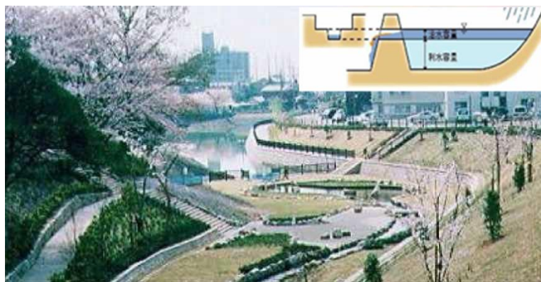
（事例）ため池を改良した流域貯留施設
