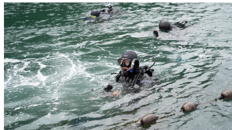
囲い網設置のための潜水作業
