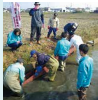
④ 集落総出で魚道を設置
