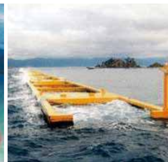
③ 消波施設の整備
