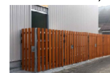
CNF含有塗料により変色が 抑制され美観維持に効果的
