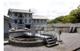
漁業集落排水施設
