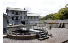
漁業集落排水施設
