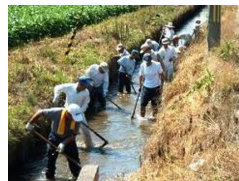
水路の泥上げ
