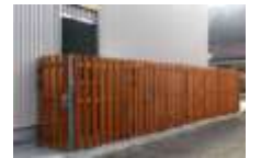
CNF含有塗料により変色が 抑制され美観維持に効果的
