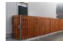
CNF含有塗料により変色が 抑制され美観維持に効果的
