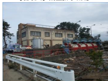
【名取川】関上排水機場
