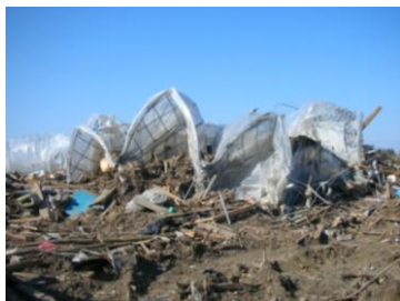
被災した園芸施設
