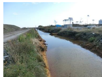
【仙台東】大堀排水路
