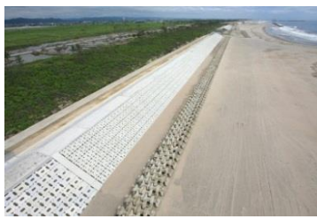
海岸堤防の復旧状況
