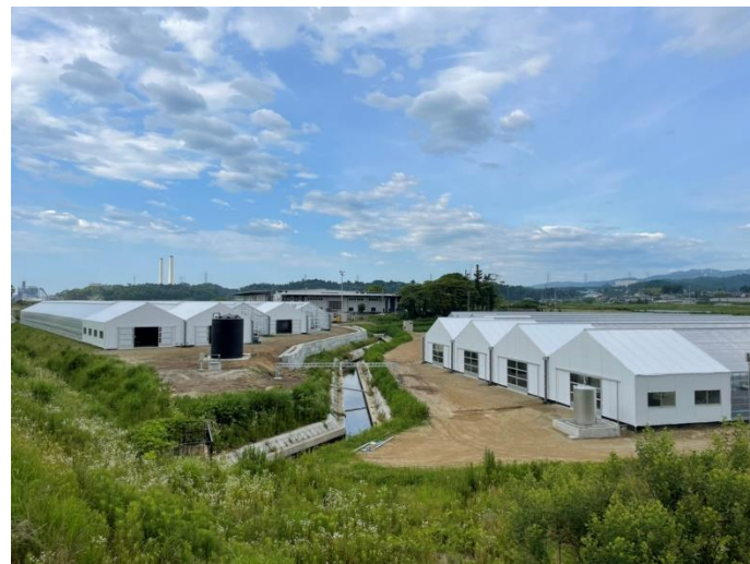
完成したかんしょの高品質苗の供給施設（桧葉町）
