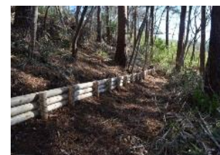
土砂移動抑制のため、筋工を施工
