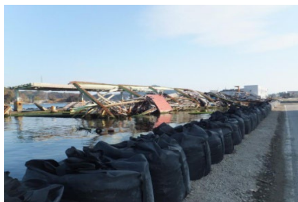
荷さばき所の被害状況
